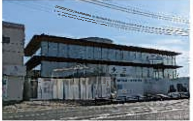
▲新社屋の足場解体時。 (2025年11月撮影)
